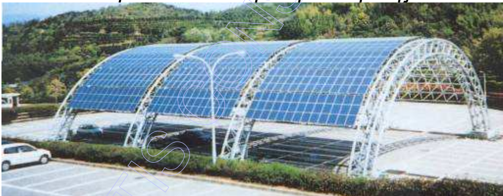
Καμπύλο Φ/Β Σκέπαστρο Χώρου Στάθμευσης
